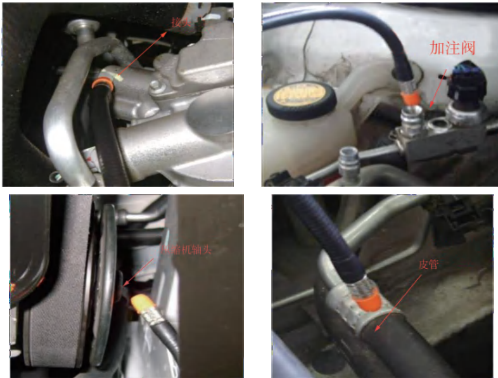
图 2-9 空调系统常见泄露部位示例
