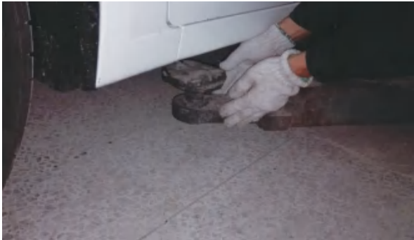
(1) 调整举升机支撑臂
